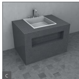
C Rivestire la struttura con le proprie piastrelle.
